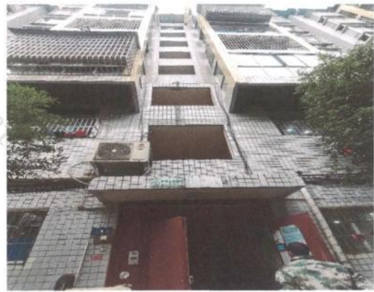
估价对象楼栋外观
