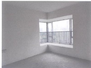
估价对象室内现状
