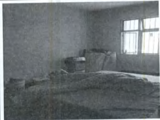
估价对象内部现状
