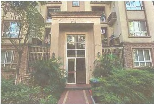
估价对象楼栋出入口
