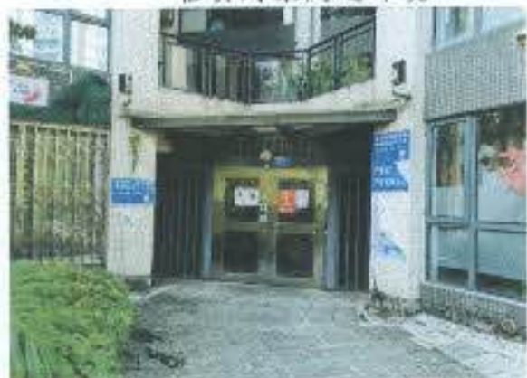
估价对象楼栋出入口
