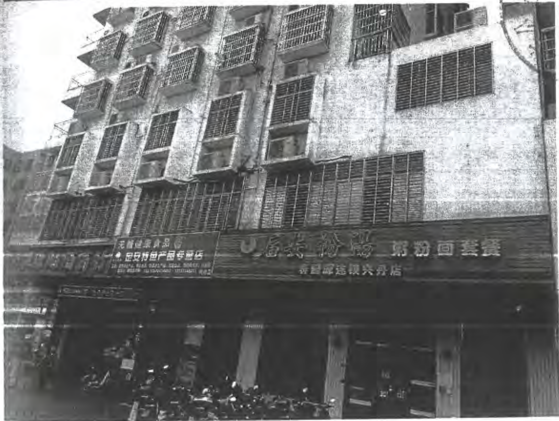
甘波的铺面，三层，位于：海口市琼山区兴丹路 德胜华庭
