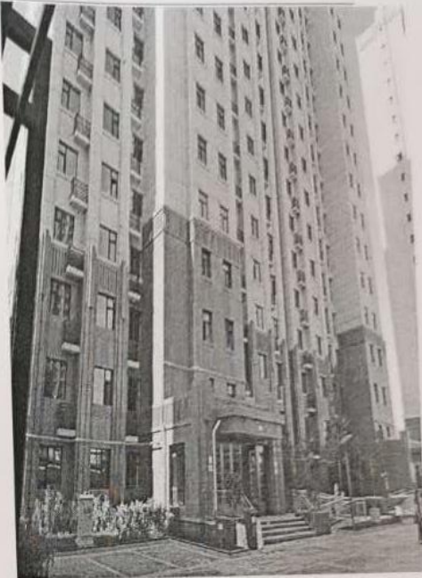
楼栋外立面照片
