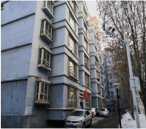
估价对象建筑
