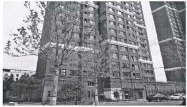
估价对象 1-3 所在楼外景
