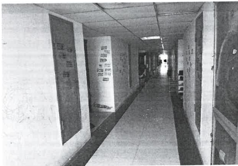
室内情况（公共走廊）
