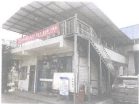
估价对象 2 外观现状
