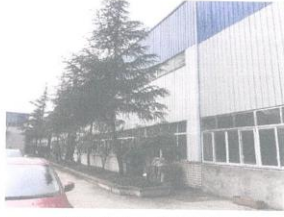
估价对象 1 外观现状
