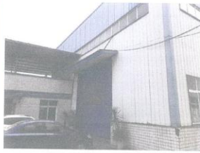
估价对象4外观现状
