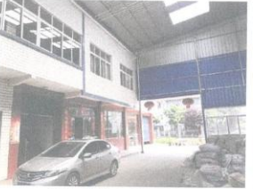
估价对象 3 外观现状
