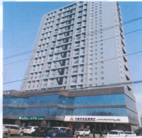
估价对象楼栋
