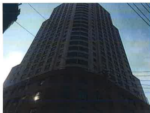
建筑物外立面
