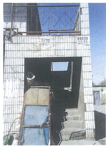
估价对象二层楼梯
