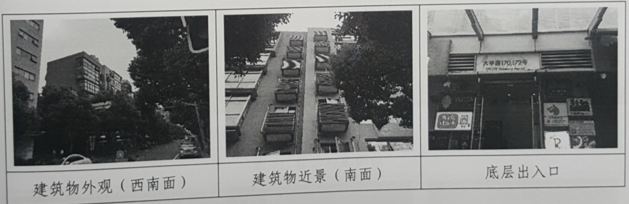
图 3: 估价对象所在办公项目
