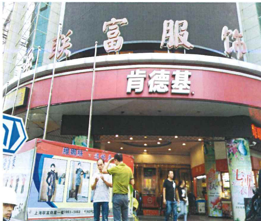
估价对象实景照 (拍摄于 2015 年)
